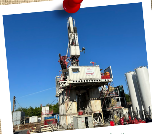
3 varmepumpeanlæg med geotermisk varme som varmekilde
