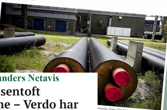
varme. Foto: Tim Kildeborg
