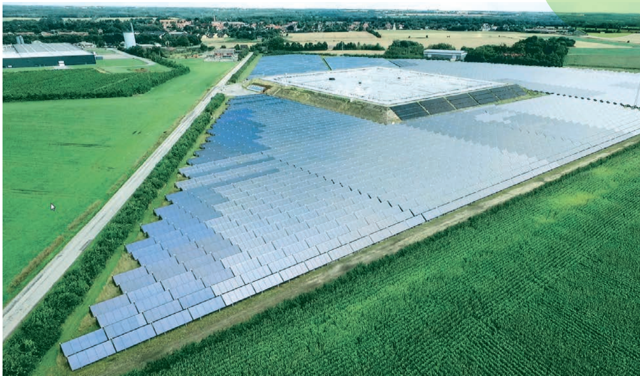
Gram Fjernvarme har etableret storskala solvarme og damvarmelager.
