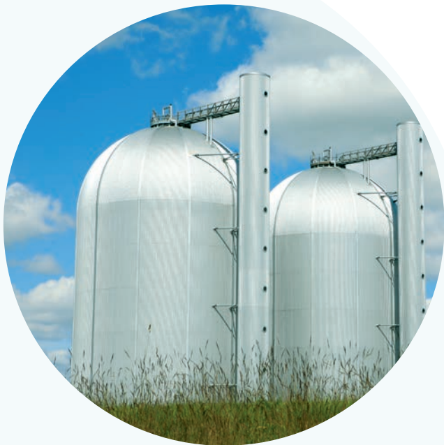
Varmelagertanke på Avedøreværket.
